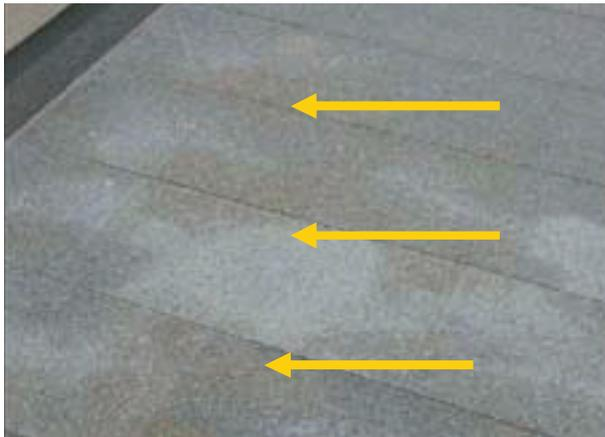
Abbildung 1: Blick auf einen Teil des Natursteinverbundes. Es sind optisch sichtbare rötliche bis bräunliche Verfärbungen / Flecken zu erkennen (mit Pfeilen markiert).
