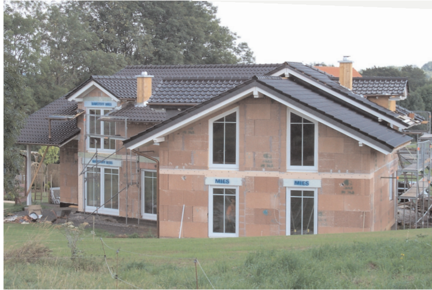
Großformatige Wandelemente verkürzen die Bauzeiten im Massivbau. (BV)
